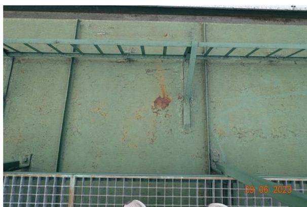
Bilder 6 bis 9: Korrosionsschäden des Blechdaches
